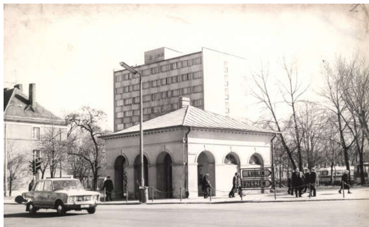
Rys. 4. Materiały dotyczące zabezpieczenia i zagospodarowania budynku Rogatki Warszawskiej w Radomiu [5]
